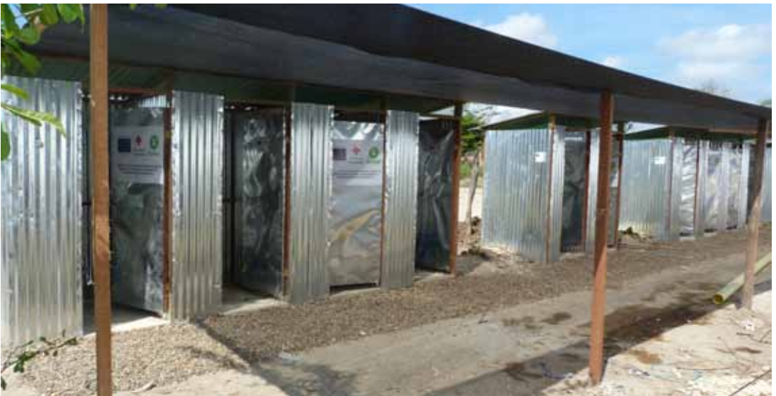
Letrina Elevada y Húmedas para zonas de clima húmedo e inundables
