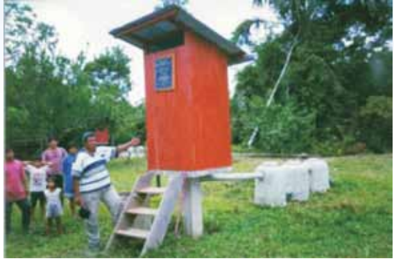
Letrina Elevada y Húmedas para zonas de clima húmedo e inundables
